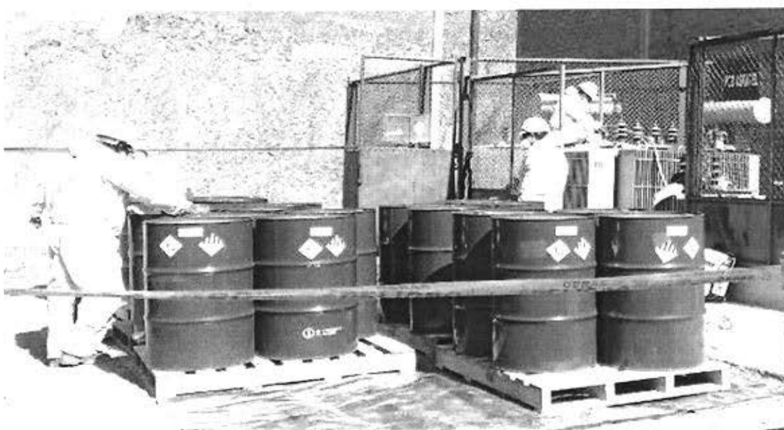
Figura N° 19: Barriles/tambores cerrados tipo ONU conteniendo aceite con PCB listo para ser transportado hacia el Puerto
