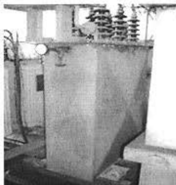
Figura N° 12: Transformadores de subestaciones presentan pérdidas y manchas de aceite tanto en equipos como en la instalación
