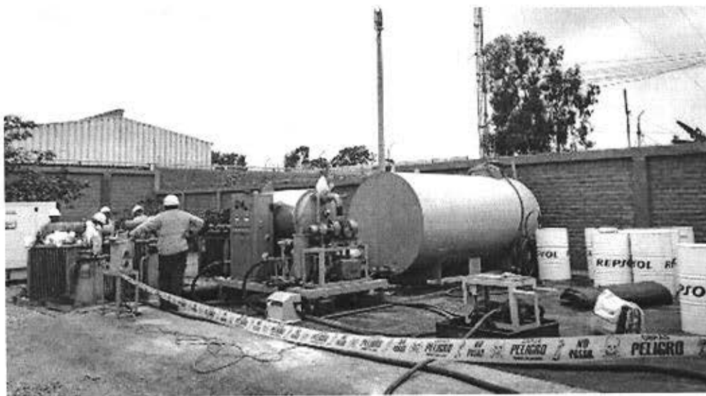
Figura N° 29: Equipo utilizado para el proceso de retrolleado
